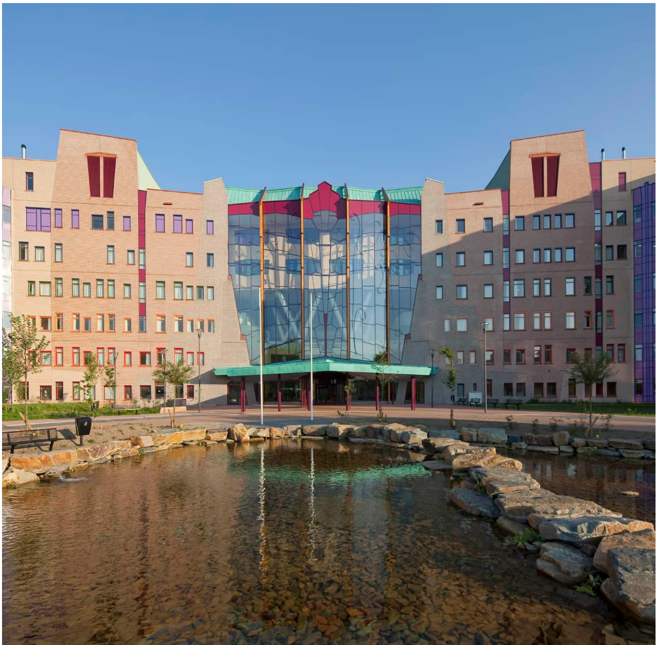
Tussen de metselwerk vlinders worden de bezoekers ontvangen in de beglaasde entreehal
